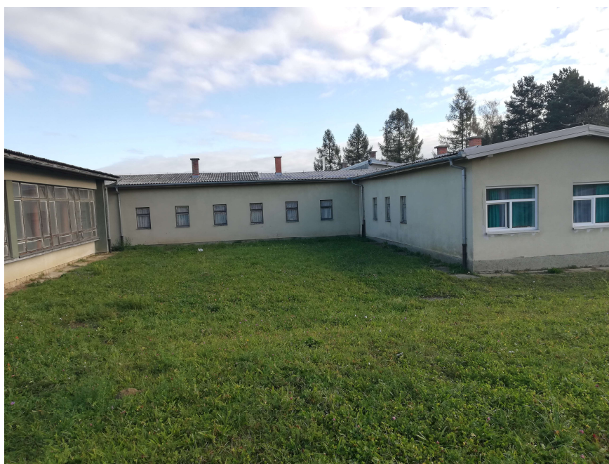
Slika 3.2 Jugozapadno pročelje zgrade
