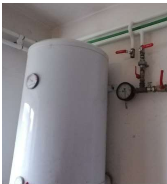
Slika 3.4.2 Postojeći spremnik za pripremu PTV-a
