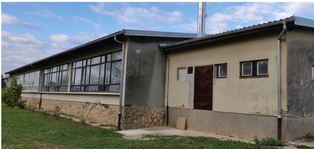
Slika 3.1 Ulazno(jugoistočno) pročelje zgrade i kotlovnica
