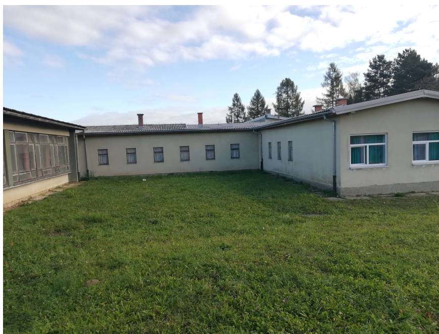
Slika 3.2 Jugozapadno pročelje zgrade
