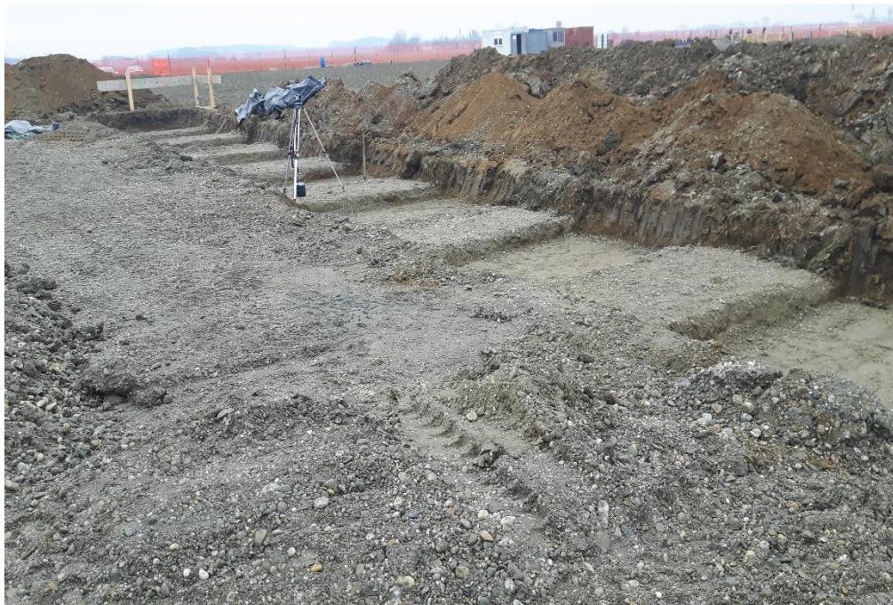
Slika 5. Strojni iskop jame za temeljne stope
