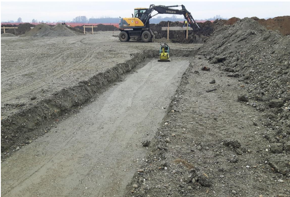
Slika 3. Strojni iskop jame
