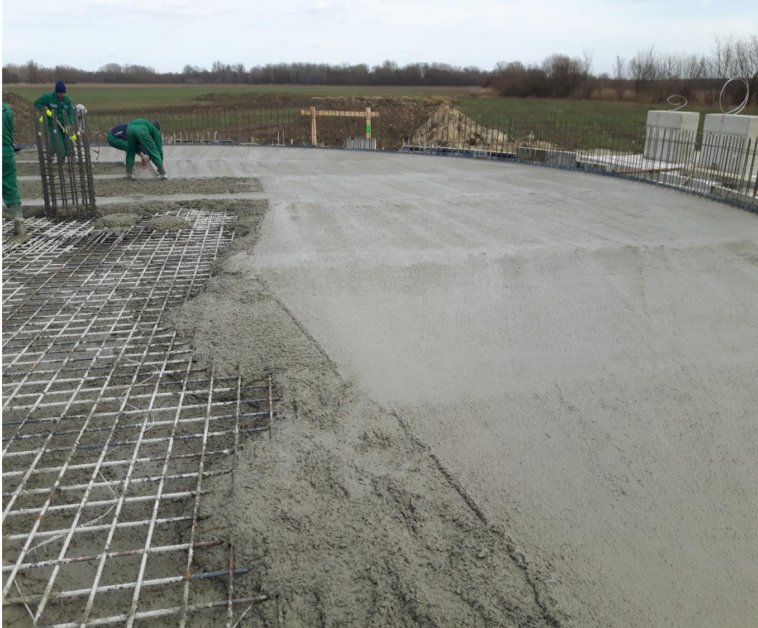
Slika 7. Betoniranje AB podne ploče postdigestora
