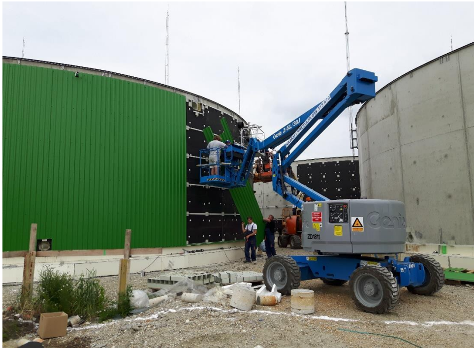
Slika 14. Stavljanje lima na digestor i postdigestor
