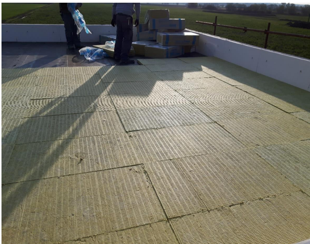
Slika 12. Postavljanje toplinske izolacije
