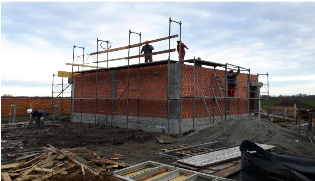
Slika 8. zidanje energetske građevine- trafostanice
