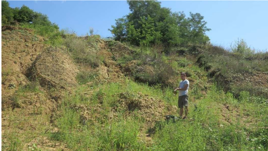
Slika 7.7. Mjerenje karakterističnog nagiba ispod istražne bušotine B10[1]
