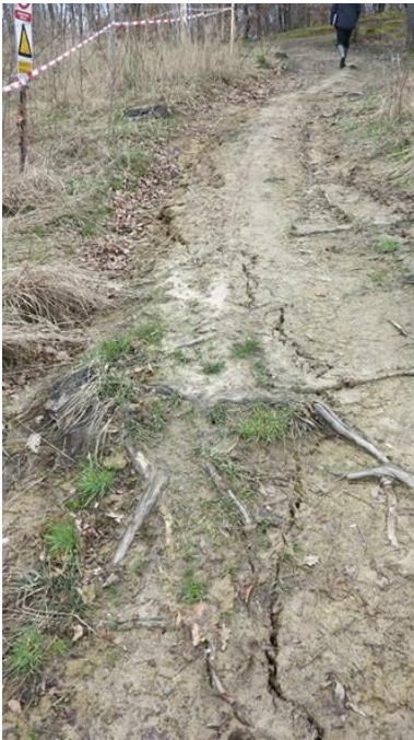
Slika 4.5. Vlačna pukotina uz čeonu rub glinokopa [1]
