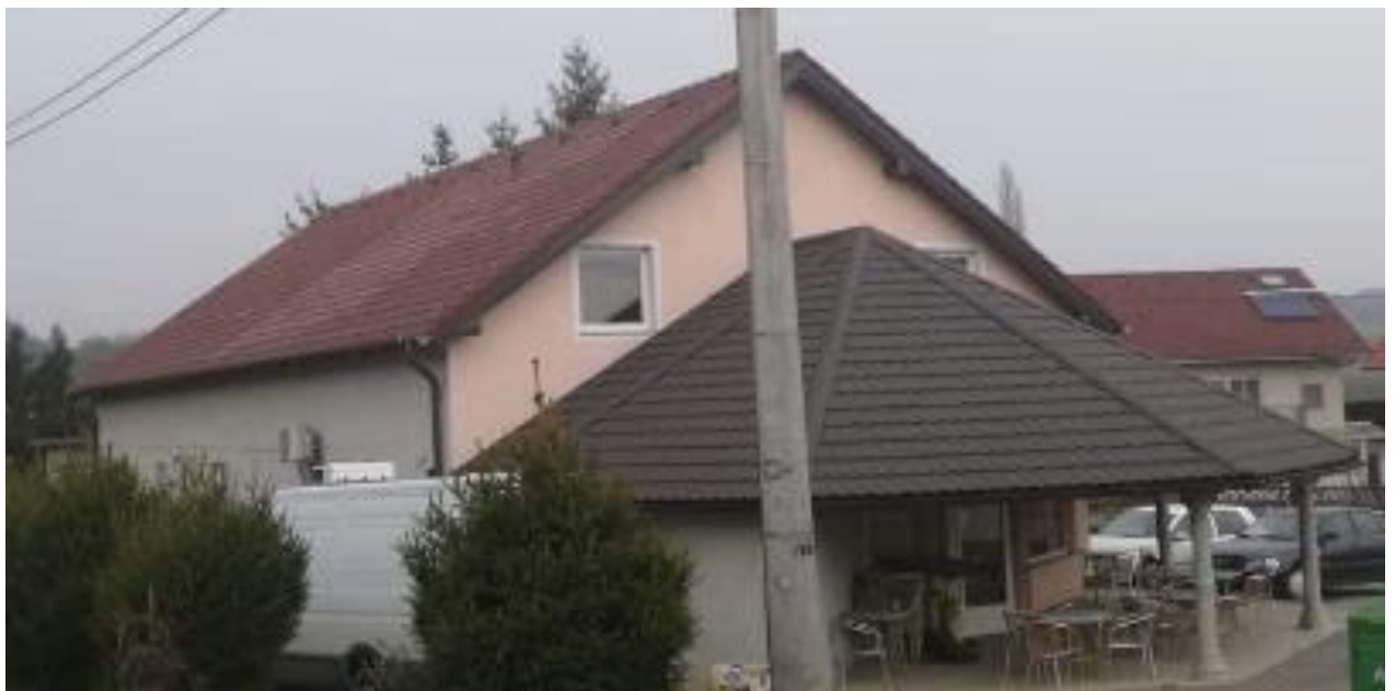
Slika 2 Jugoistočno i Jugozapadno pročelje
