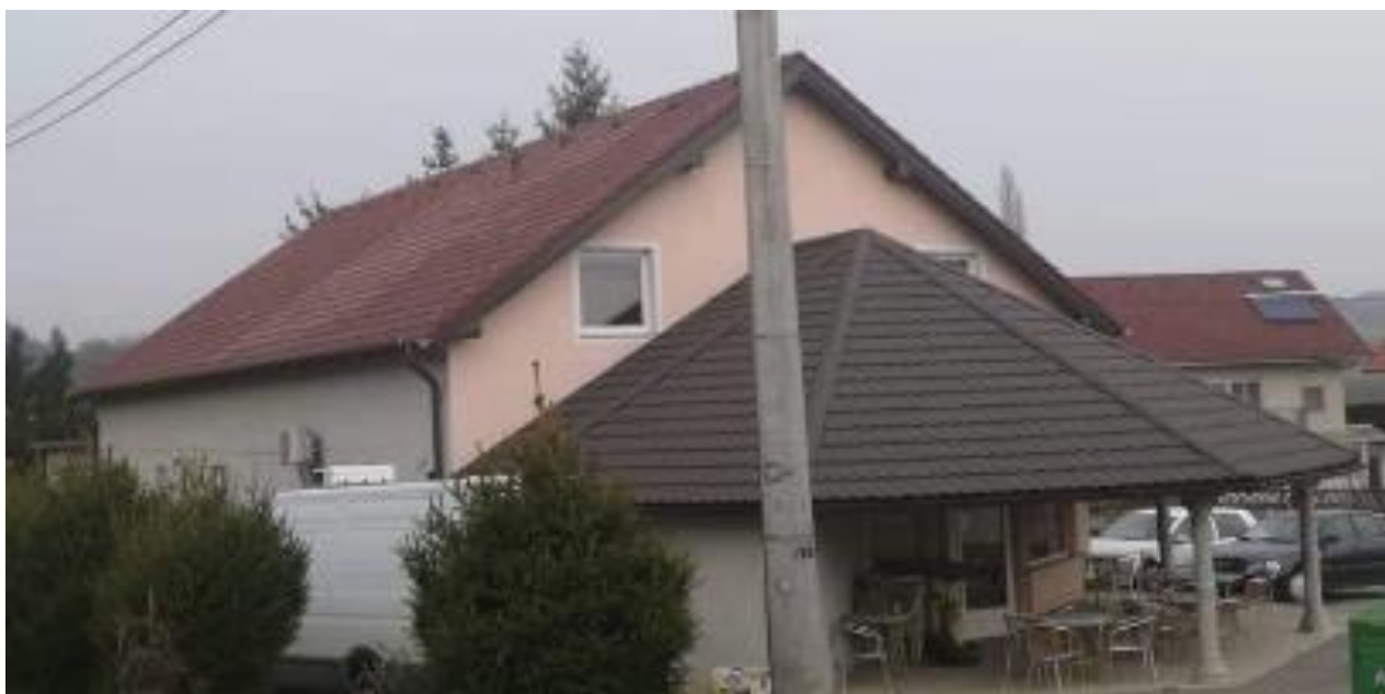
Slika 2 Jugoistočno i Jugozapadno pročelje
