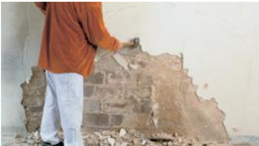
Slika 3.4.2.. Skidanje stare boje sa zida
