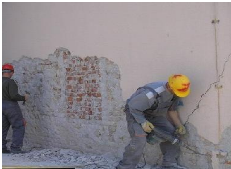
Slika 3.2.1. Otucanje stare žbuke sa zidova
