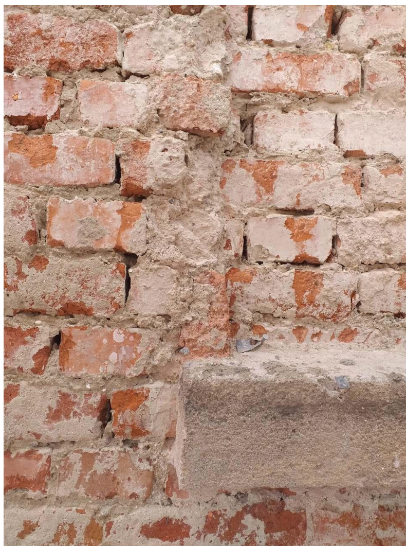
Slika 3.2.2. Stanje zida nakon skidanaja žbuke
