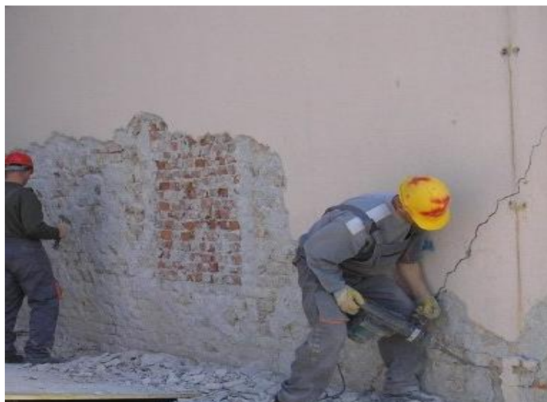
Slika 3.2.1. Otucanje stare žbuke sa zidova
