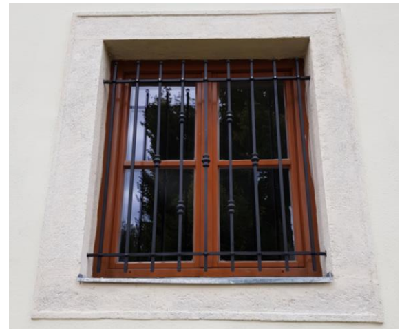
Slika 3.7.4. Restaurirani kameni prozorski okvir
