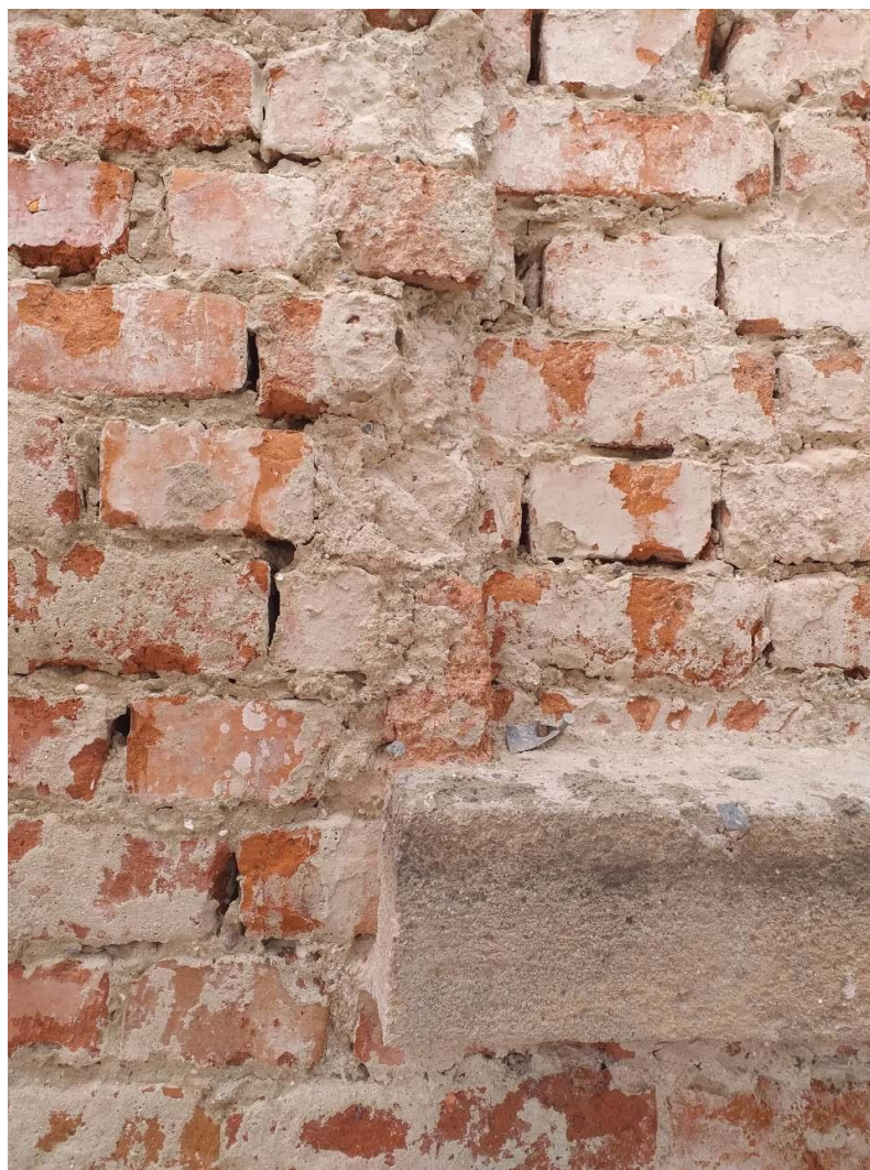
Slika 3.2.2. Stanje zida nakon skidanaja žbuke
