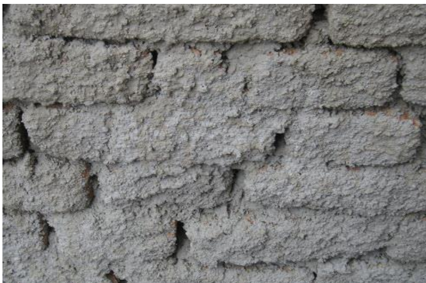
Slika 3.4.1. Nanošenje šprica
