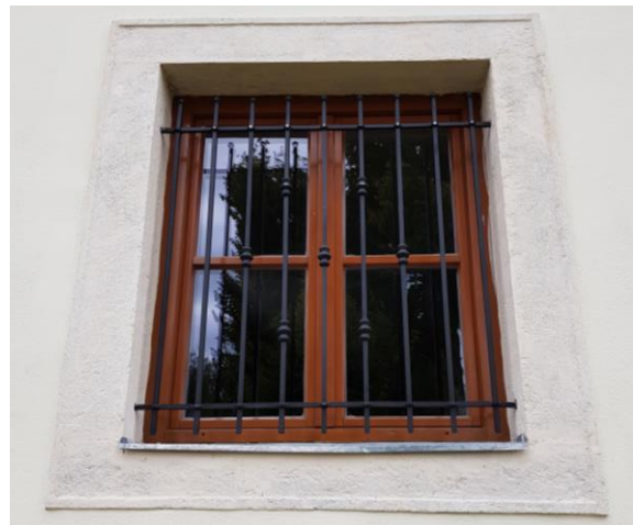
Slika 3.7.4. Restaurirani kameni prozorski okvir
