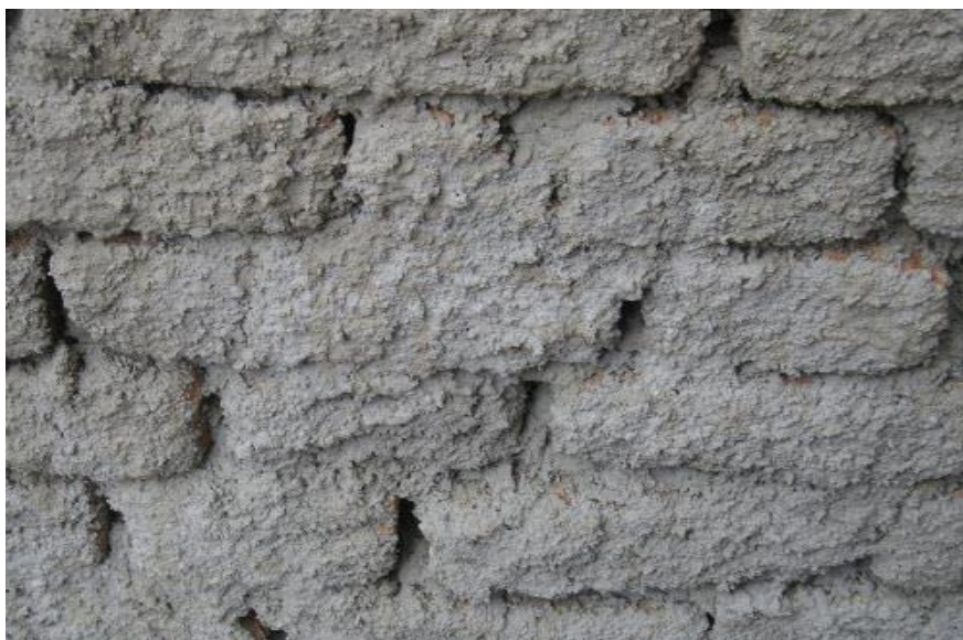
Slika 3.4.1. Nanošenje šprica
