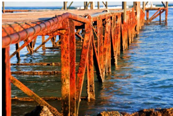
Slika 18.: Primjer utjecaja morske vode na koroziju [18]
