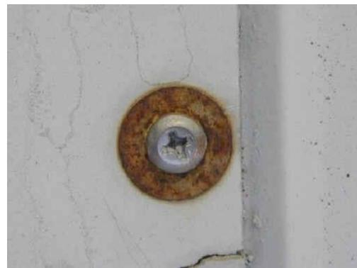
Slika 9.: Primjer kontaktne korozije [8]
