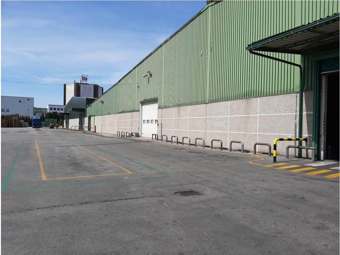
Slika 11 Ulaz skladišta za utovar robe
