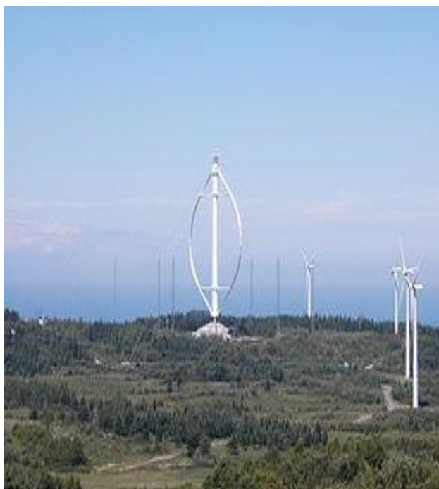
Slika 3.9. Darrieusov vjetroagregat [12]
