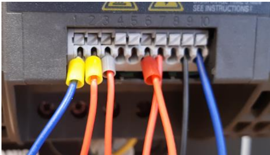
Slika 6.1 Izgled spoja terminale frekvencijskog pretvarača G110
