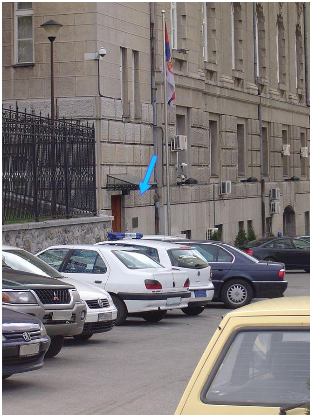
Slika 6. Ulaz broj 5 zgrade Vlade Republike Srbije
