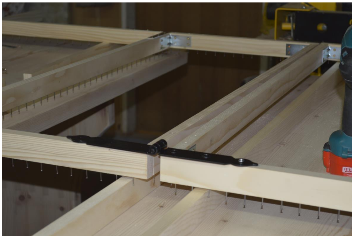
Slika 5.30. Proces stavlja većih pantica za spajanje lijeve i desne strane okvira instalacije
