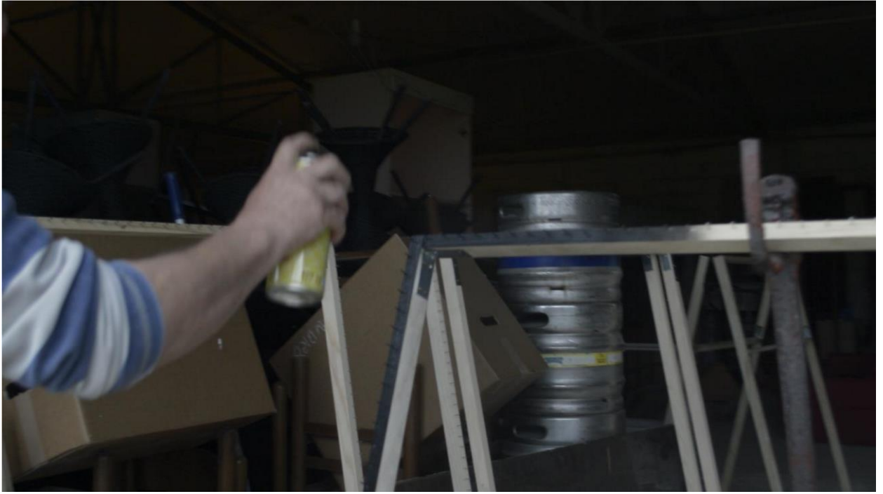
Slika 5.31. Proces sprejanja okvira
