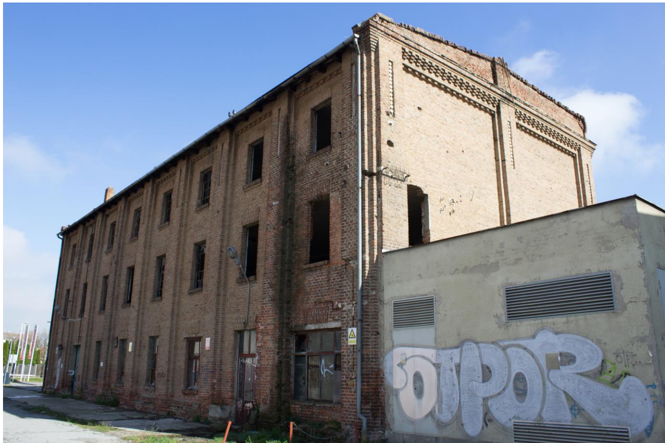
Slika 3.3 Objekt s Vinkovačke ceste - Tvornica alata/Mobilia d.d.
