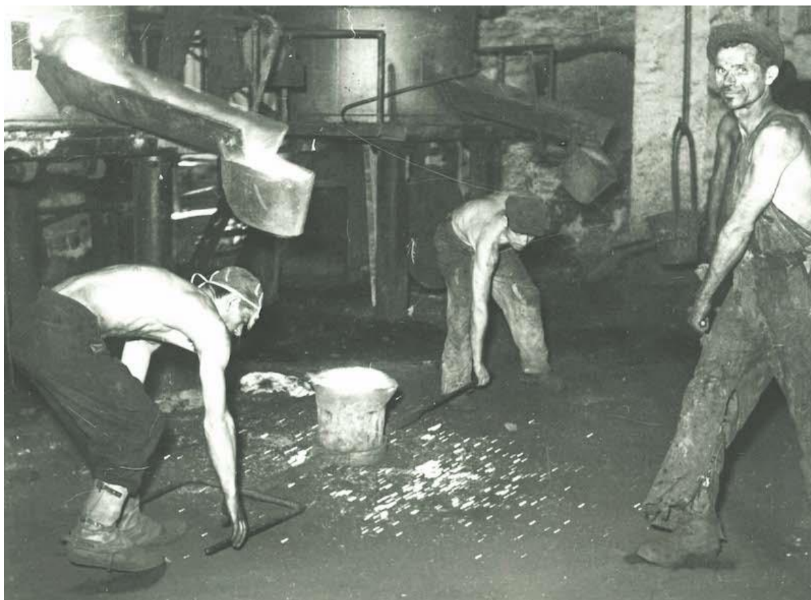
Slika 3.10 Radnici u Osječkoj ljevaonici željeza i tvornici strojeva, OLT d.d.
