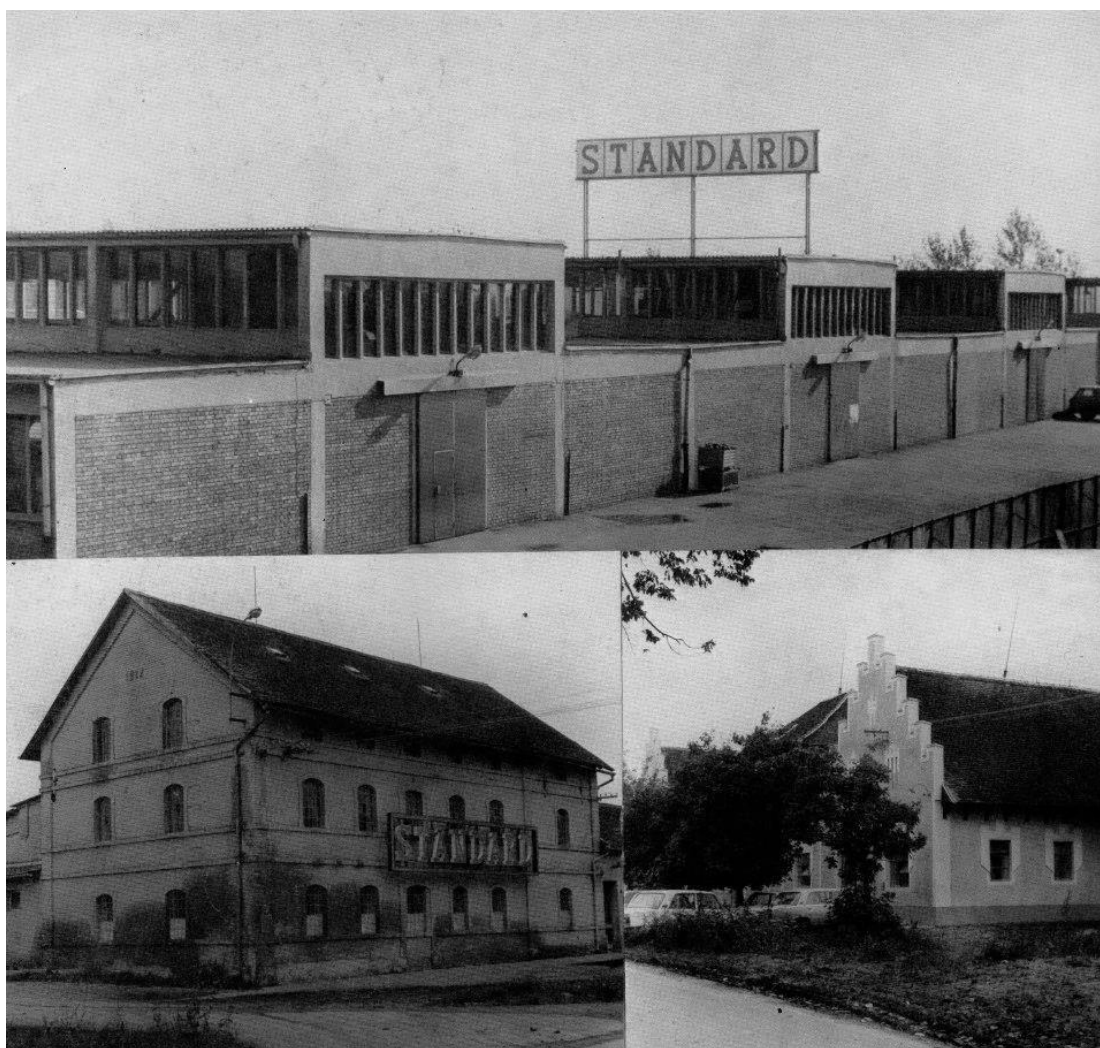
Slika 3.8 Objekti tvornice Metalska industrija d.d. Osijek 70-ih godina
