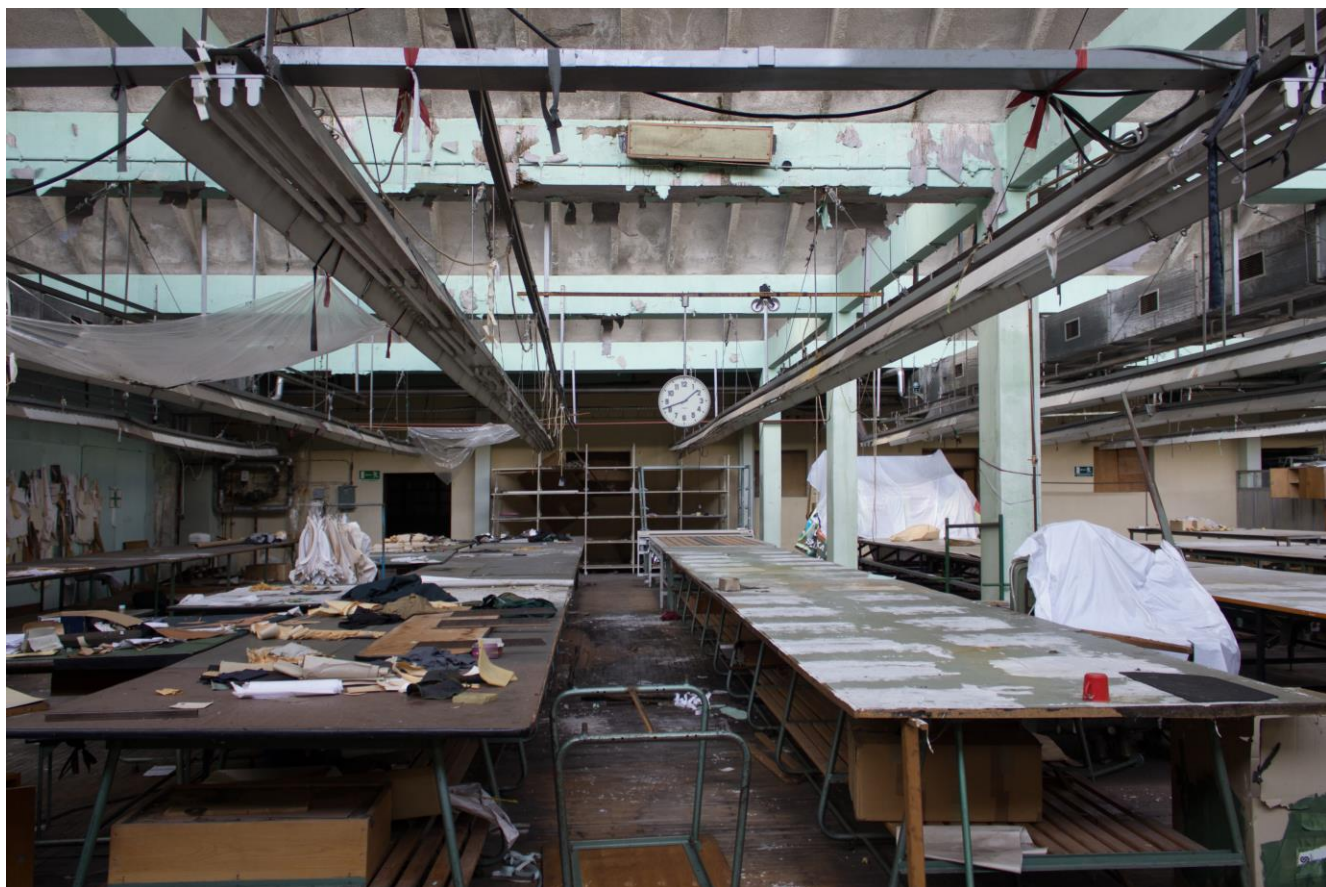
Slika 3.17 Trenutno stanje unutrašnjosti jednog objekta Slavonije MK d.d.
