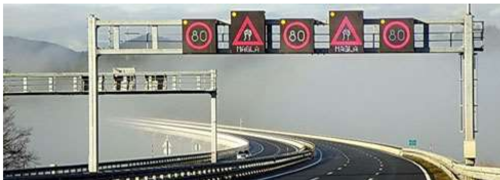
Slika 34. Svjetlosni znak za upravljanje prometom na autocesti A1
