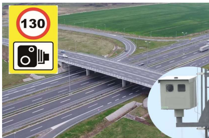
Slika 28. Prikaz nadzorne kamera na autocesti
