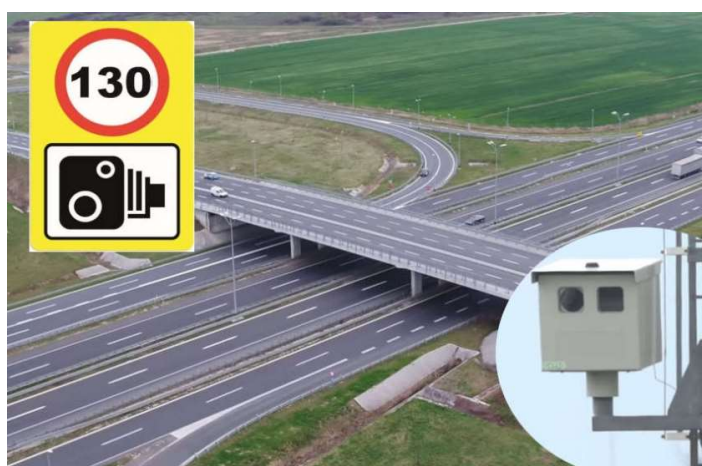
Slika 28. Prikaz nadzorne kamera na autocesti
