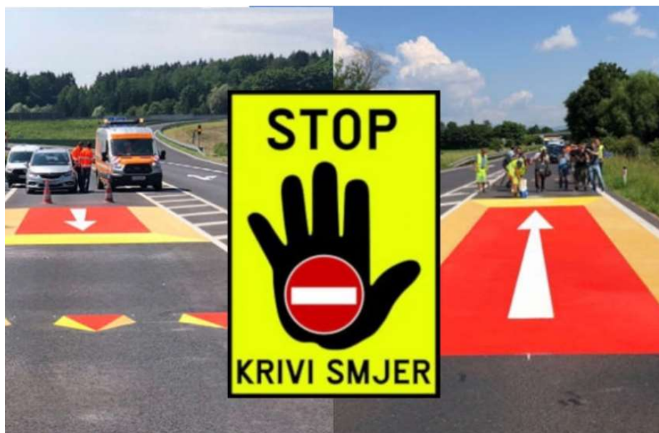
Slika 25. 3D prometna horizontalna signalizacija za sprečavanje ulaska vozila u suprotan smjer (Izvor URL: https://npscp.info/media/k2/items/cache/910084c4eb3461ee8947cd42bdd4b146_XL.jpg )
