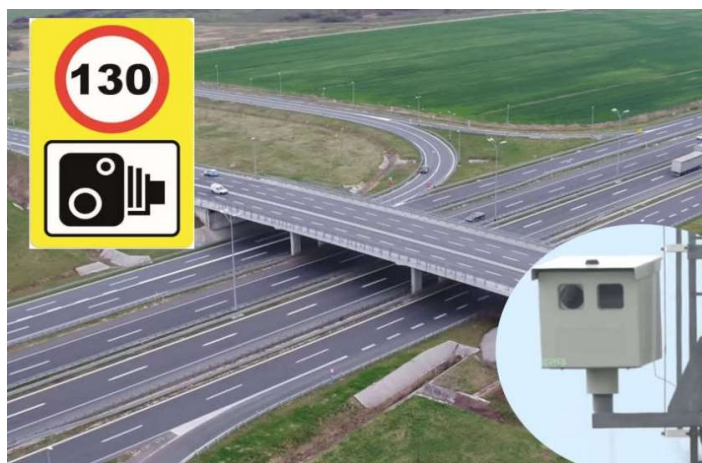
Slika 28. Prikaz nadzorne kamera na autocesti
