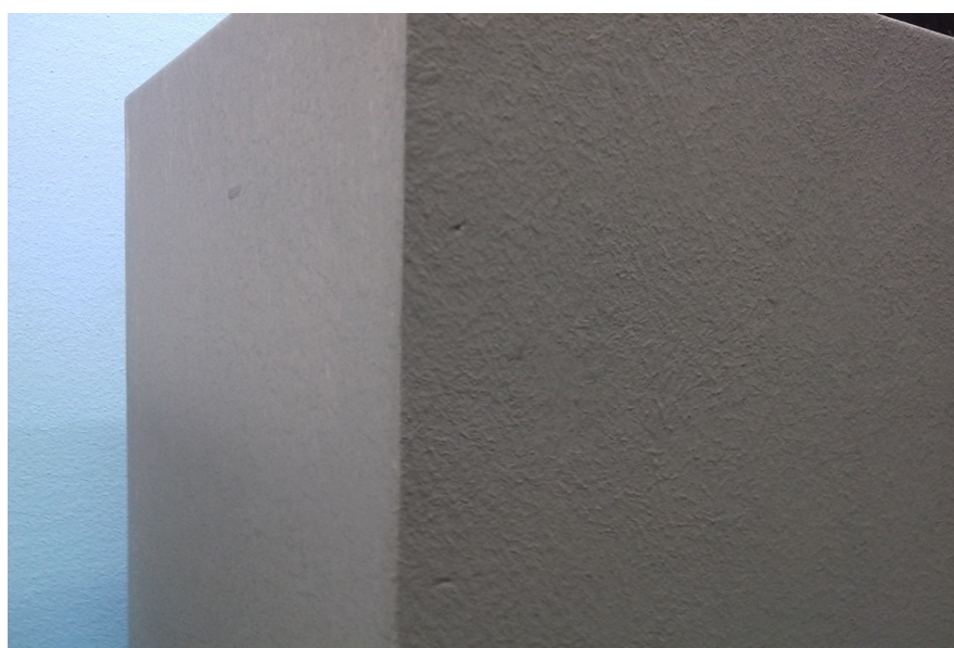
Slika 7.15. Prikaz teksture na obojanoj zgradi
