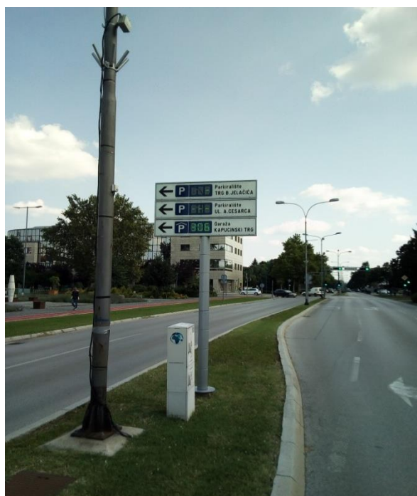
Slika 12. UPGS na lokaciji Ulica Zrinskih i Frankopana
