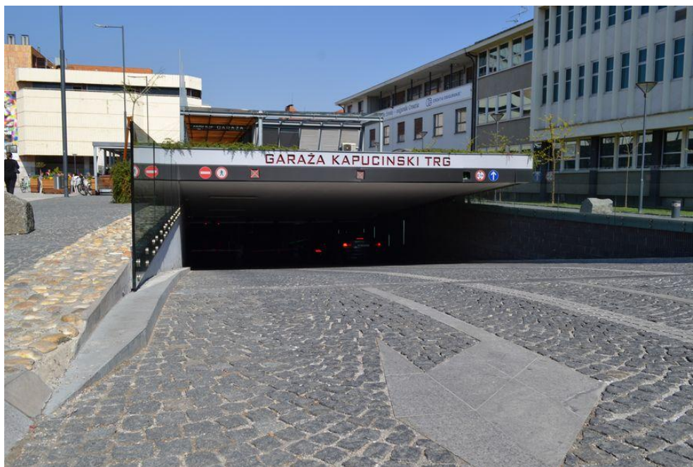
Slika 4.4. Garaža „Kapucinski trg“ – ulaz u garažu
