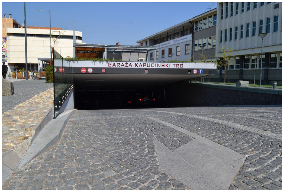
Slika 4.4. Garaža „Kapucinski trg“ – ulaz u garažu
