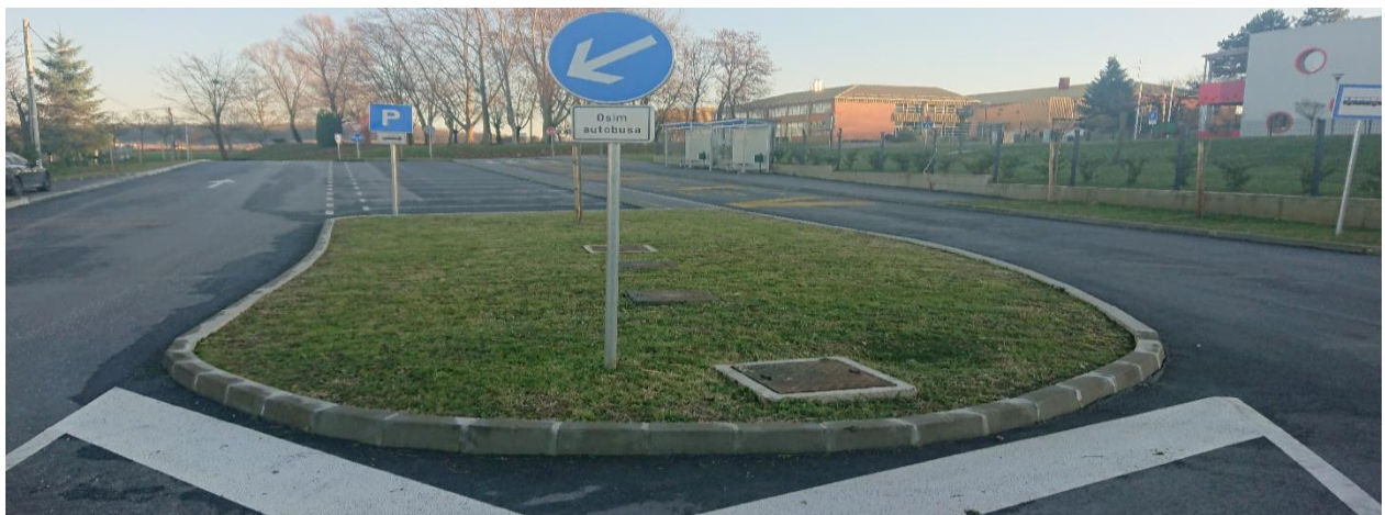
Slika 3.4. Odvojeni prometni trakovi prilazne ceste prema osnovnoj školi i dječjem vrtiću
