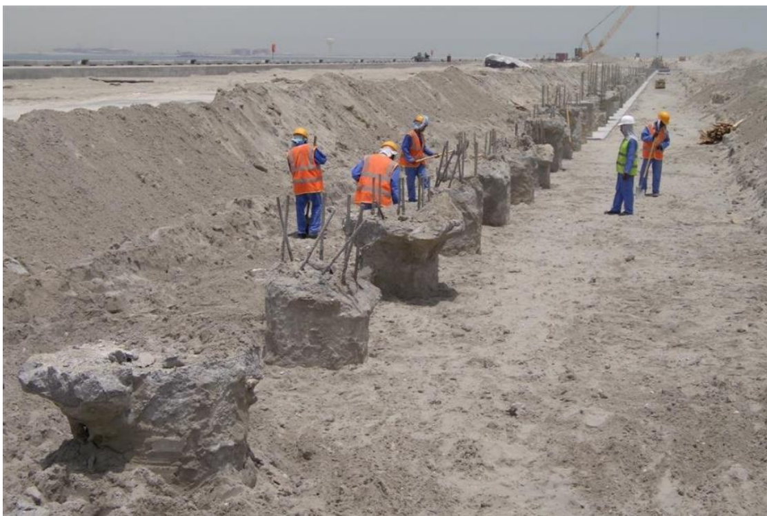
Slika 3.4. Piloti na koji će se izgraditi temeljni nosač za kransku stazu lučne dizalice; Izvor: https://mapio.net/pic/p-2522726/
