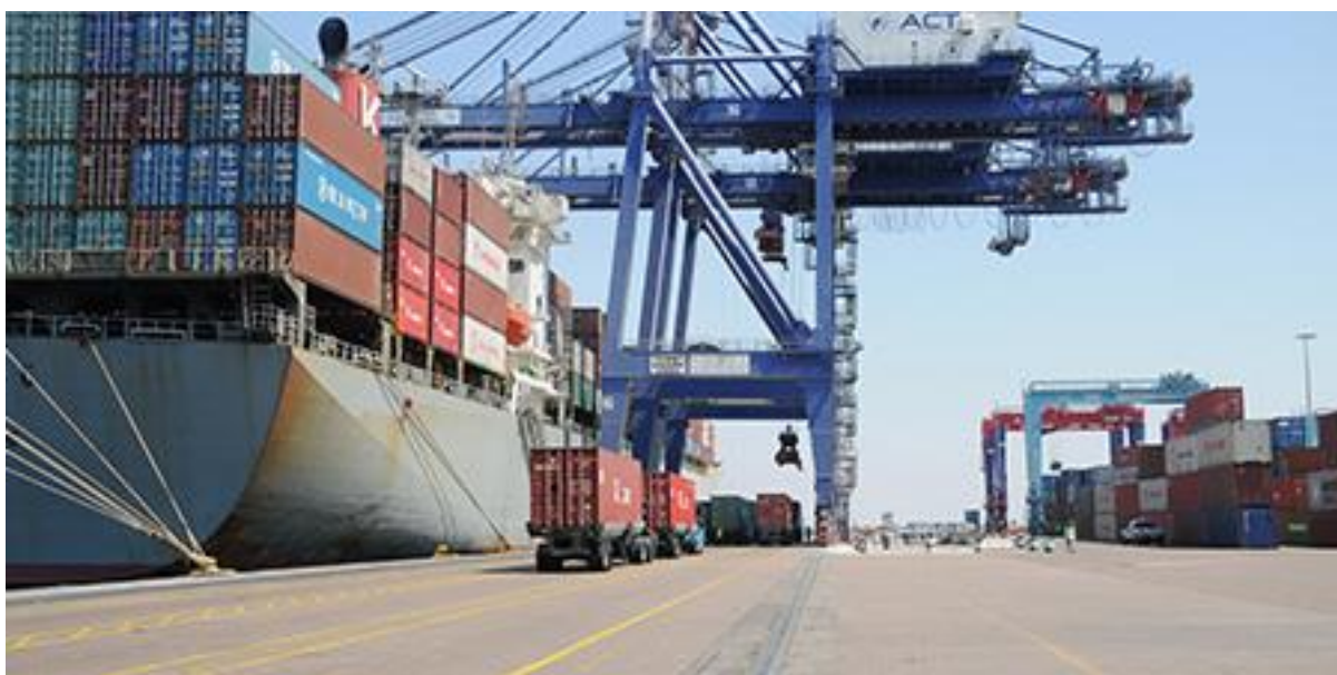
Slika 3.3. Dizalica u luci za pretovar kontejnera; Izvor: https://www.gantrail.com/sectors/marine-sector/
