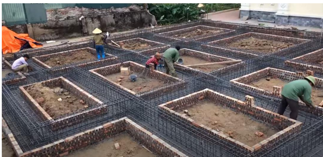
Slika 4.2. Armiranje elastičnih temeljnih nosača na tlu; Izvor: https://www.youtube.com/watch?v=4G3a_xkg8k8
