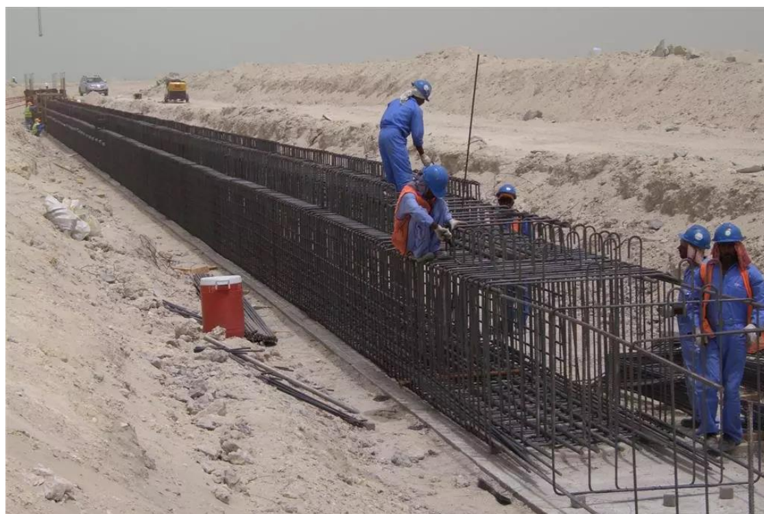
Slika 3.5. Armiranje temeljnog nosača kranske staze za lučnu dizalicu; Izvor: https://mapio.net/pic/p-2353656/
