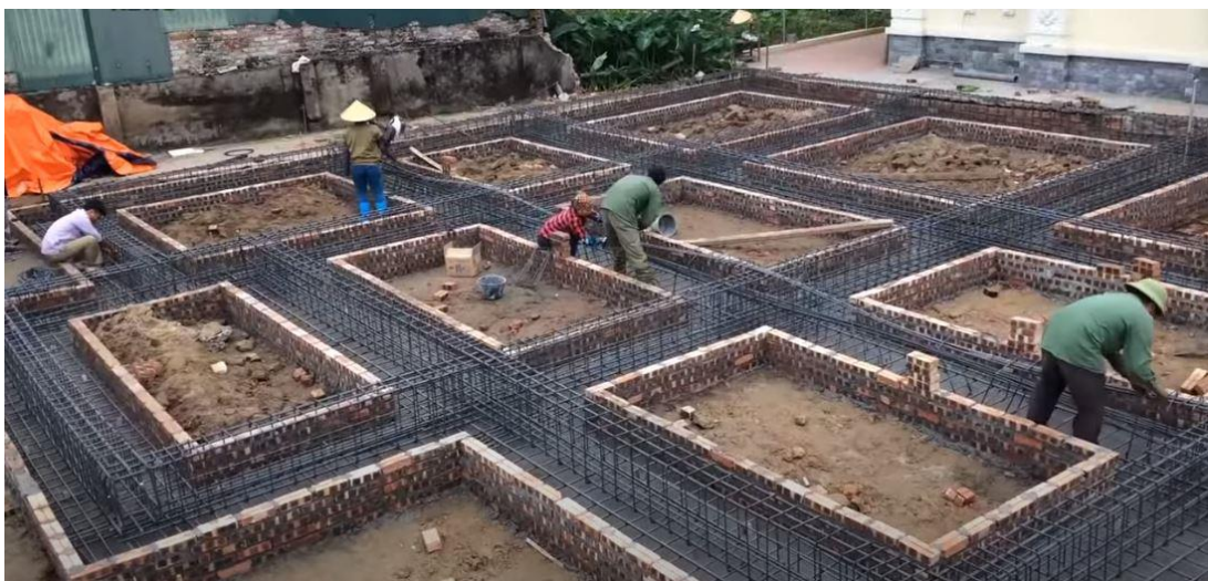
Slika 4.2. Armiranje elastičnih temeljnih nosača na tlu; Izvor: https://www.youtube.com/watch?v=4G3a_xkg8k8
