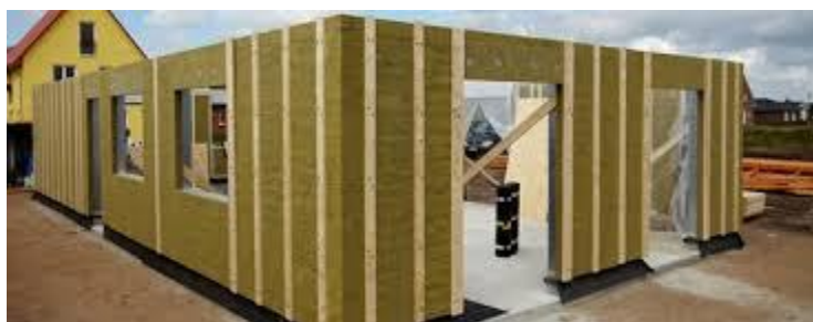
Slika 10, primjena izolacijskih materijala u montažnim građevinama
