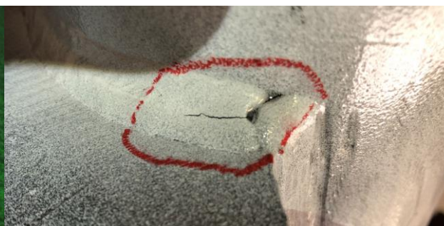
Slika 8 Pukotina zavara detektirana MT [7]
