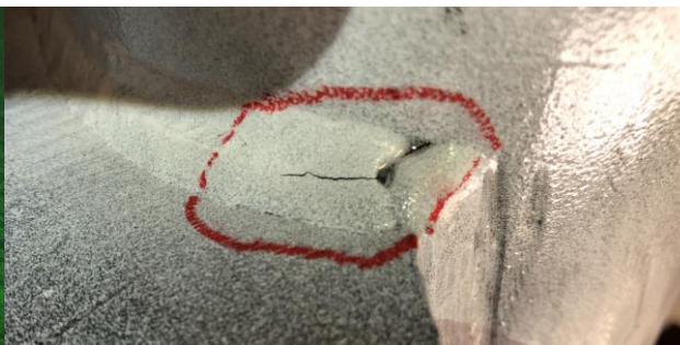
Slika 8 Pukotina zavara detektirana MT [7]
