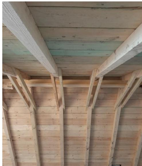
**Slika 3.5. Prikaz drvene građe krovišta: rogovi, škare, sljeme na greda, daske**
