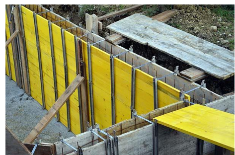
Slika 3.3. Primjer izvedbe AB zida
