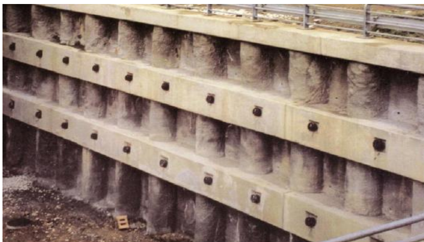
Slika 2.8. Prikaz otkopane konstrukcije izvedene pilotnim stijenama
