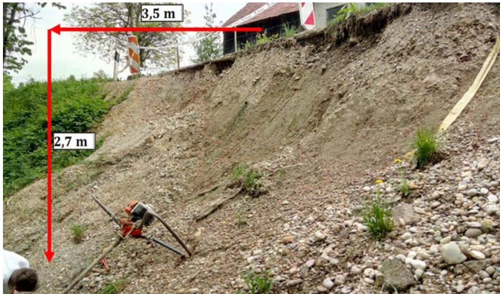
Slika 6.3. Pozicija istražne bušotine
