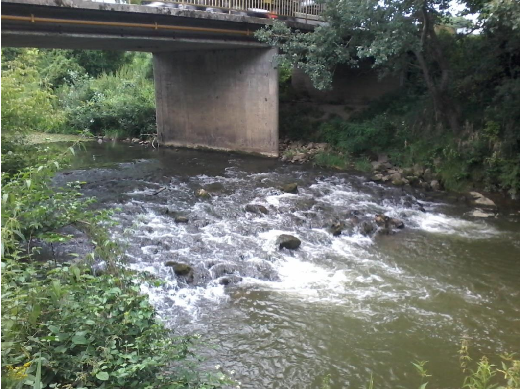
Slika 3.15 Nasuti prag te obaloutvrda ispod mosta[8]
