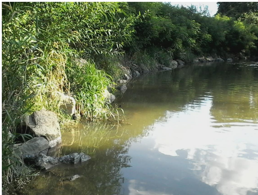
Slika 3.8. Kamena obaloutvrda(rip-rap) na desnoj obali[8]
