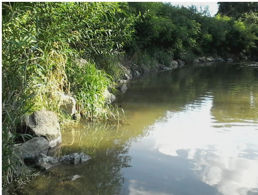
Slika 3.8. Kamena obaloutvrda(rip-rap) na desnoj obali[8]
