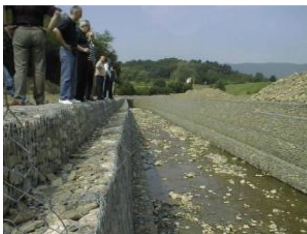
Slika 2.3. Vertikalne gravitacijska obaloutvrda od gabionskih košara [6]
