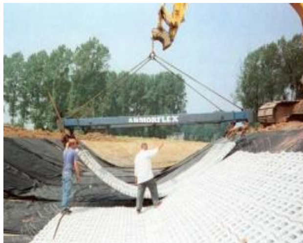
Slika 2.7. Kose obaloutvrde s oblogom od betonskih blokova[6]
