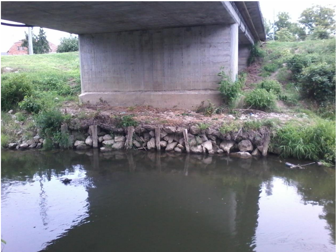
Slika 3.18. Obaloutvrda na lijevoj obali koju drže stupovi te žičana mreža[8]
