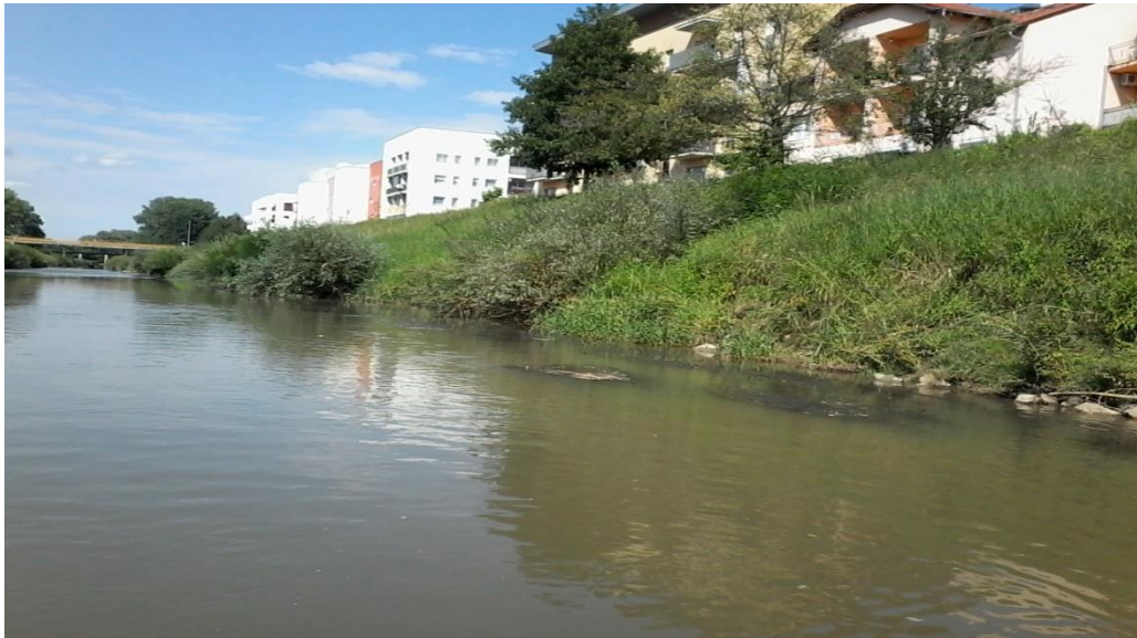
Slika 3.4. Vegetacija na obalama uzvodno od mosta[8]
