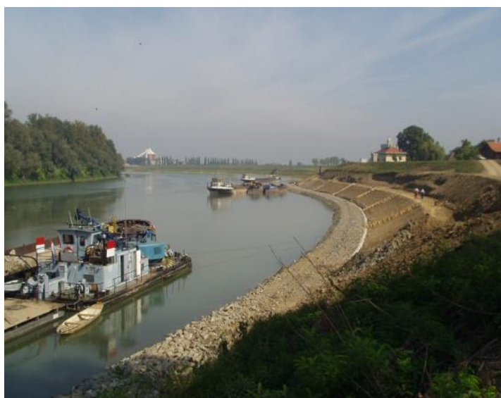
Slika 2.5. Kosa obaloutvrda s oblogom od lomljenog kamena [6]
