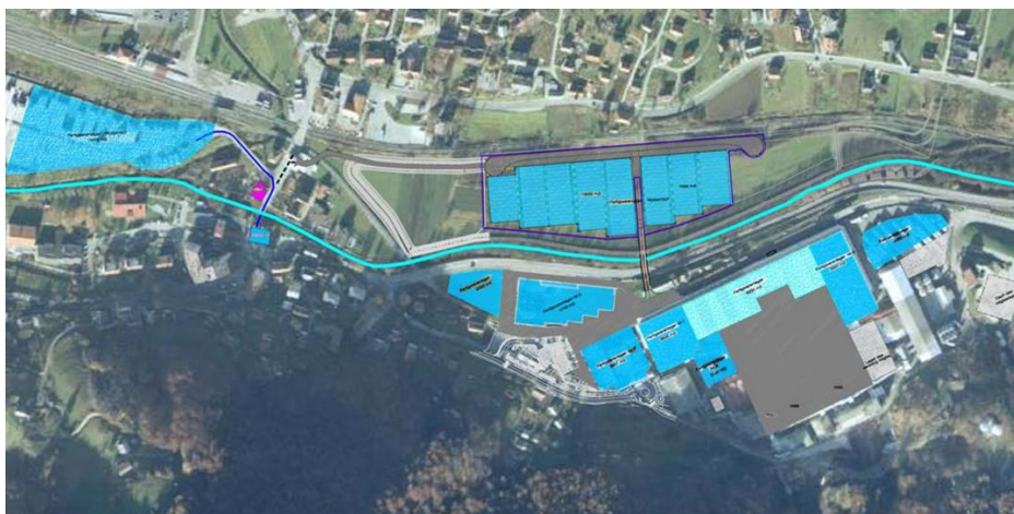
Slika 17. Skladište gotove robe
