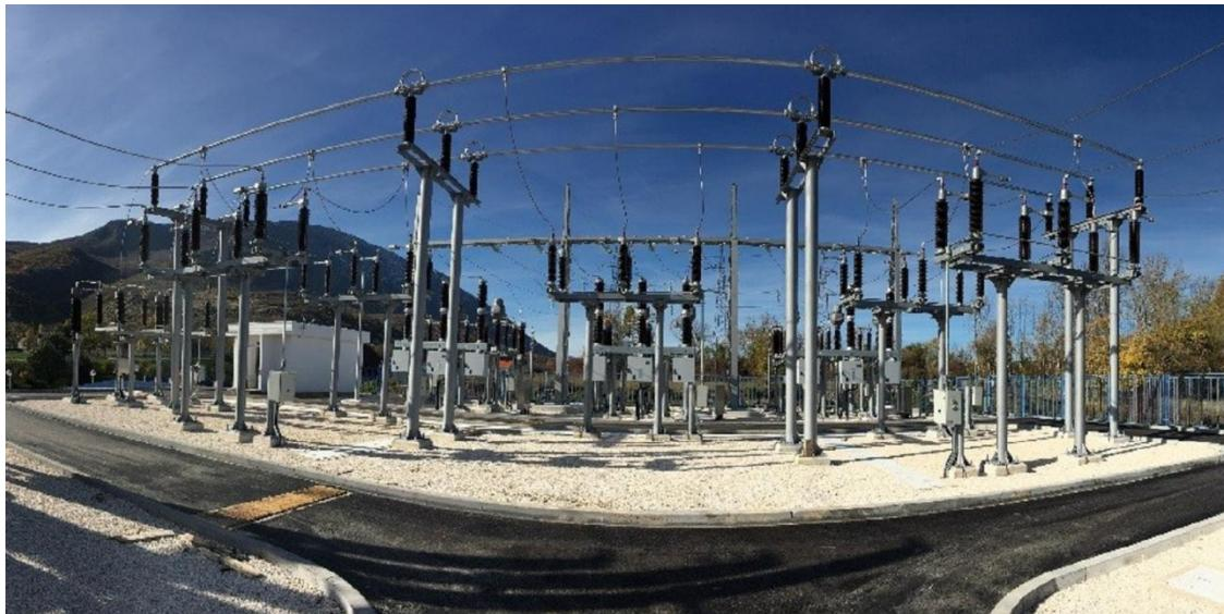
*Slika 2.4 Rasklopno postrojenje od 110 kV [7]*
