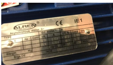
Slika 4.6 Natpisna pločica asinkronog motora ulaznog transportera
