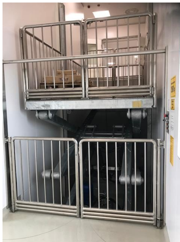
Slika 4.1 Škarasta pretovarna platforma
