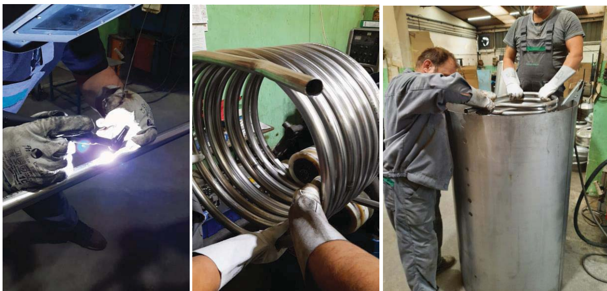
Slika 49. Izrada i zavarivanje cijevnog izmjenjivača
