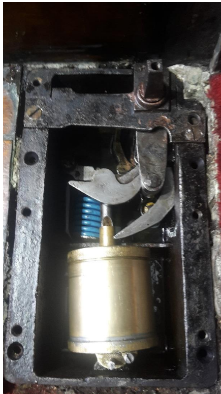
Slika 3.1: Jednoradna podna opruga za zatvaranje vrata [7]
