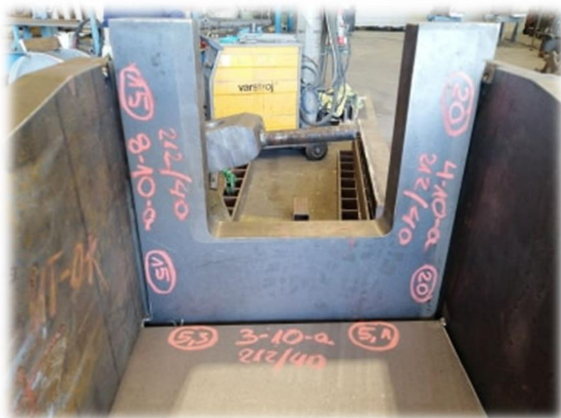
Slika 28. Označavanje i mjerenje faza prije zavarivanja
