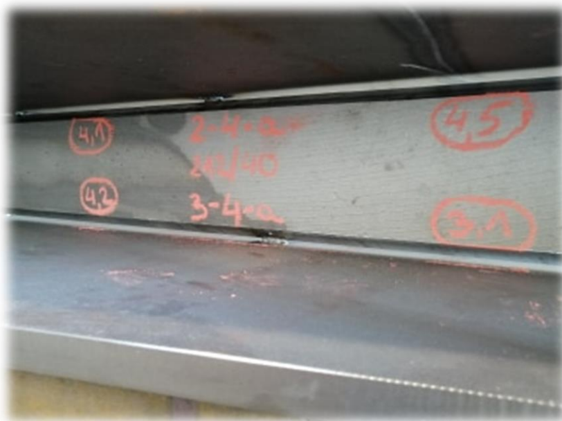
Slika 27. Označavanje i mjerenje faza prije zavarivanja
