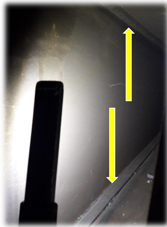
Slika 31. Dodavanje flaha i vizualna kontrola zavara [4]
