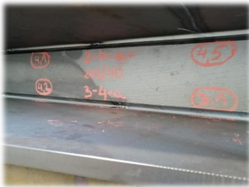
Slika 27. Označavanje i mjerenje faza prije zavarivanja
