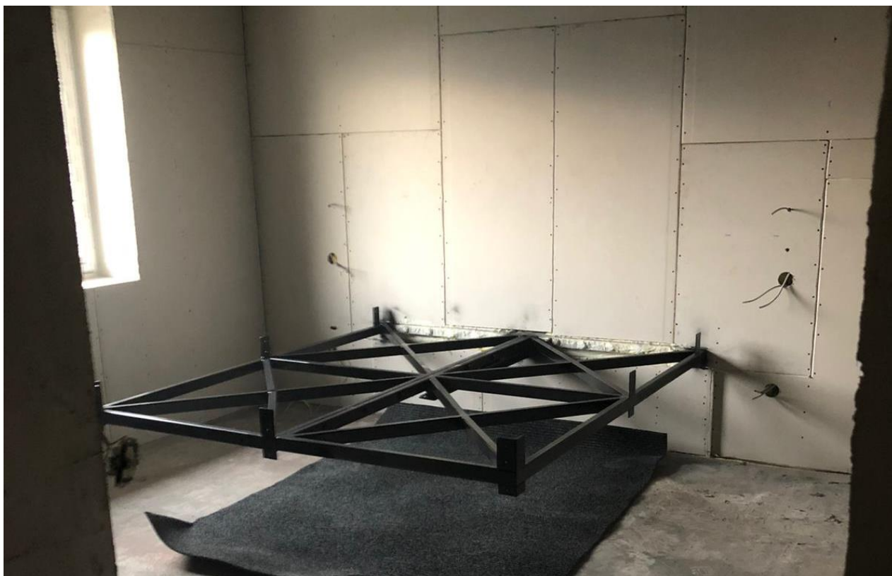
Slika 84. Antikorozivna zaštita nosive konstrukcije
