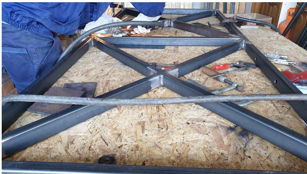
Slika 73. Zavarivanje nosive konstrukcije kreveta
