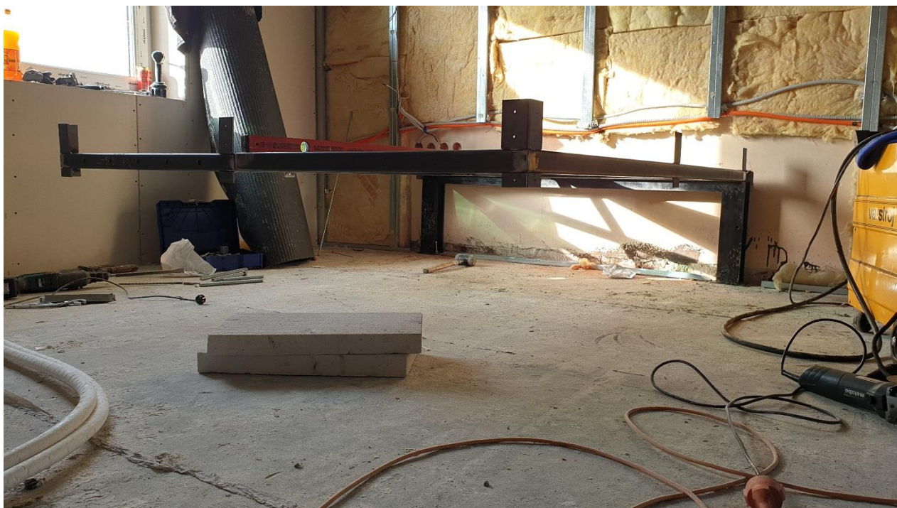
Slika 82. Završetak montaže nosive konstrukcije i konzolne potpore (2)
