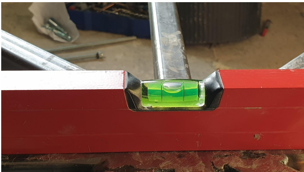
Slika 83. Provjera ravnosti površine nosive konstrukcije
