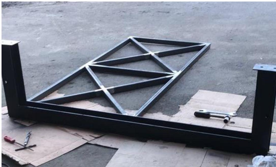
Slika 77. Probna montaža nosive konstrukcije i konzolne potpore
