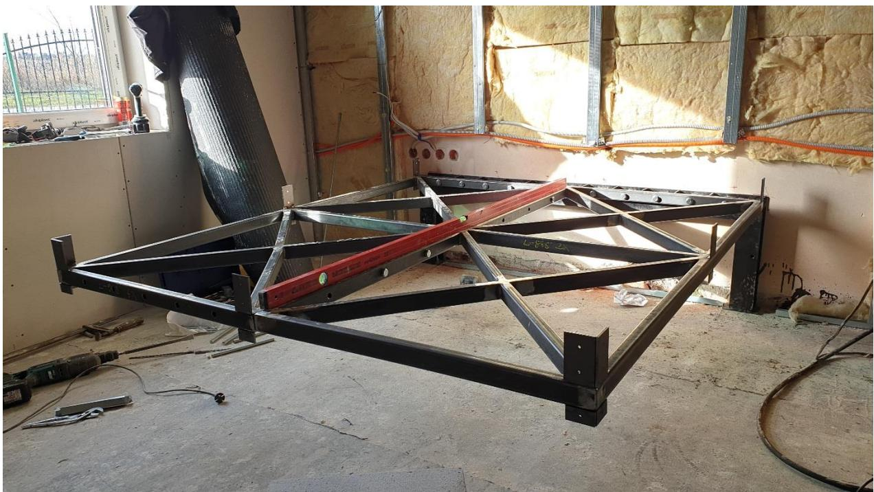
Slika 81. Završetak montaže nosive konstrukcije i konzolne potpore (1)
