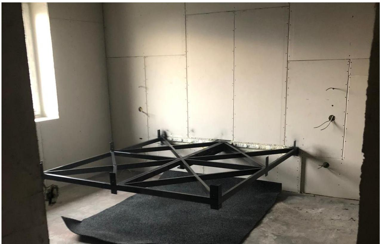
Slika 84. Antikorozivna zaštita nosive konstrukcije
