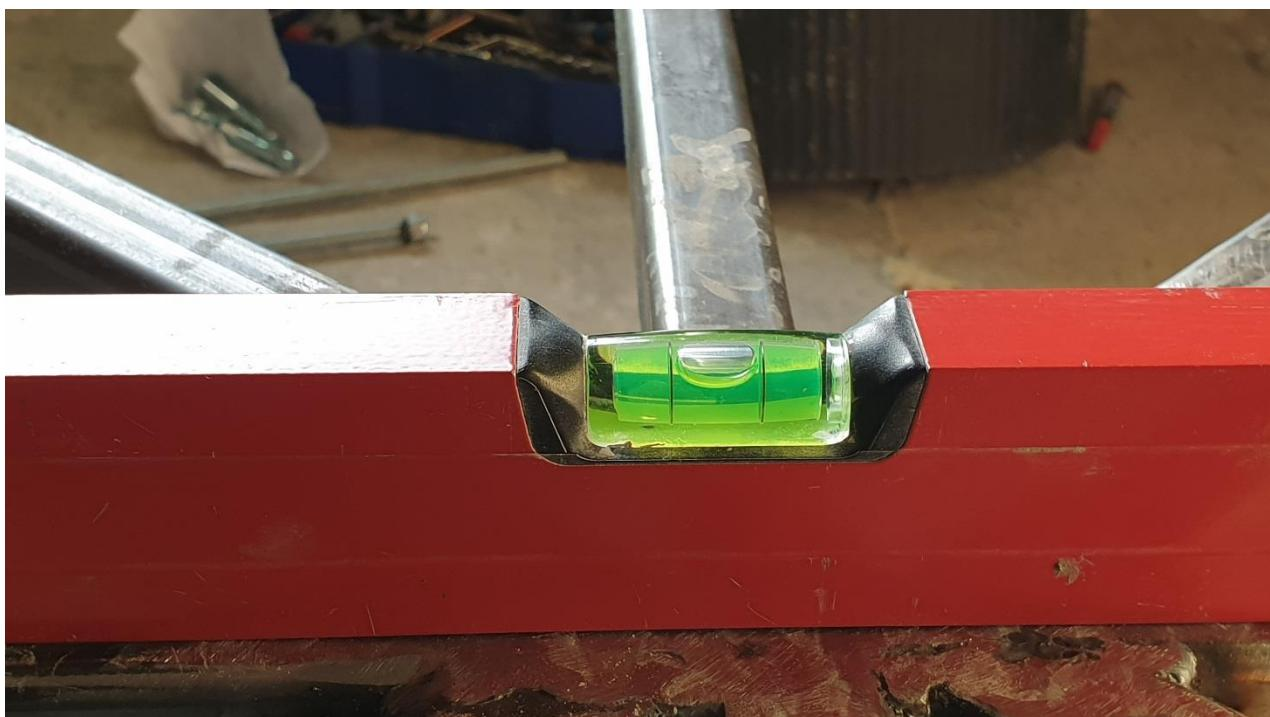
Slika 83. Provjera ravnosti površine nosive konstrukcije
