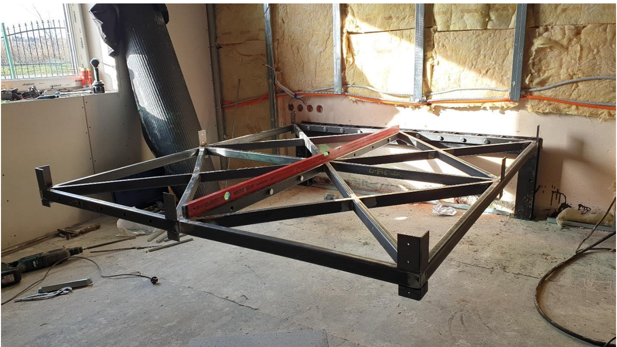
Slika 81. Završetak montaže nosive konstrukcije i konzolne potpore (1)
