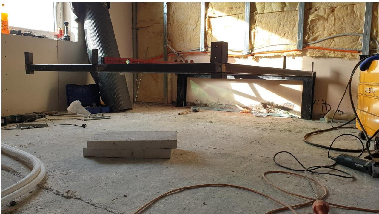
Slika 82. Završetak montaže nosive konstrukcije i konzolne potpore (2)
