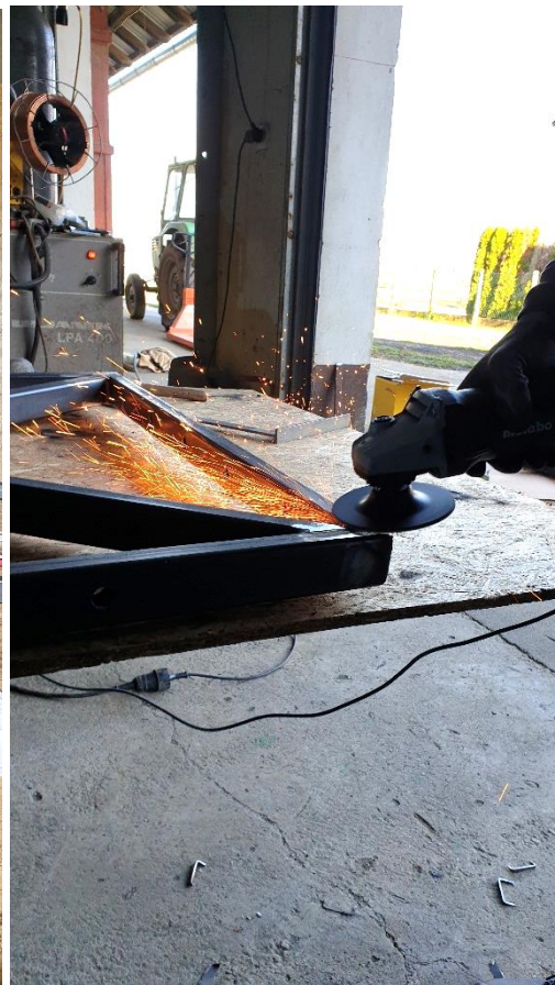
Slika 76. Brušenje zavora na čeonim spojevima
