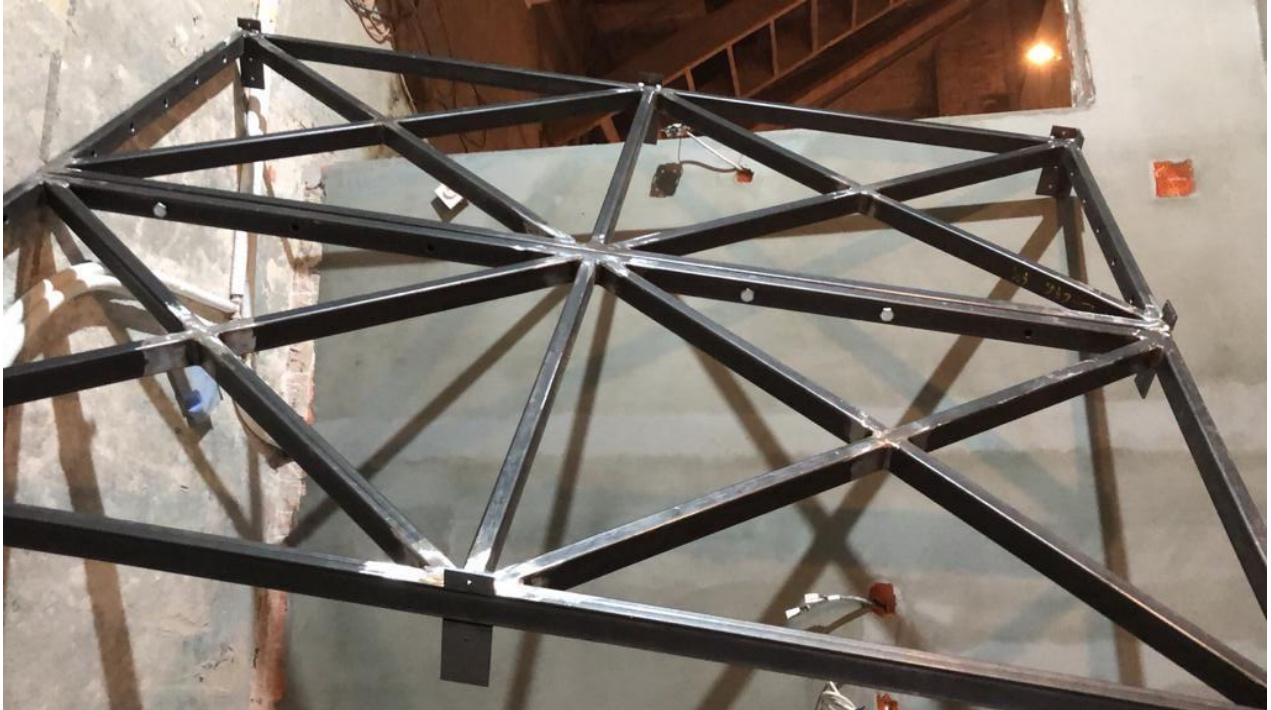
Slika 80. Nosiva konstrukcija spremna za montažu na konzolnu potporu
