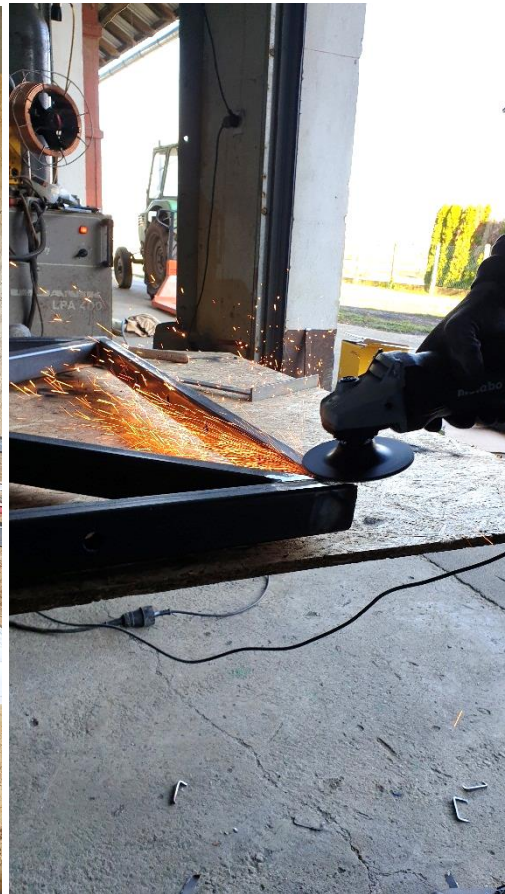
Slika 76. Brušenje zavora na čeonim spojevima
