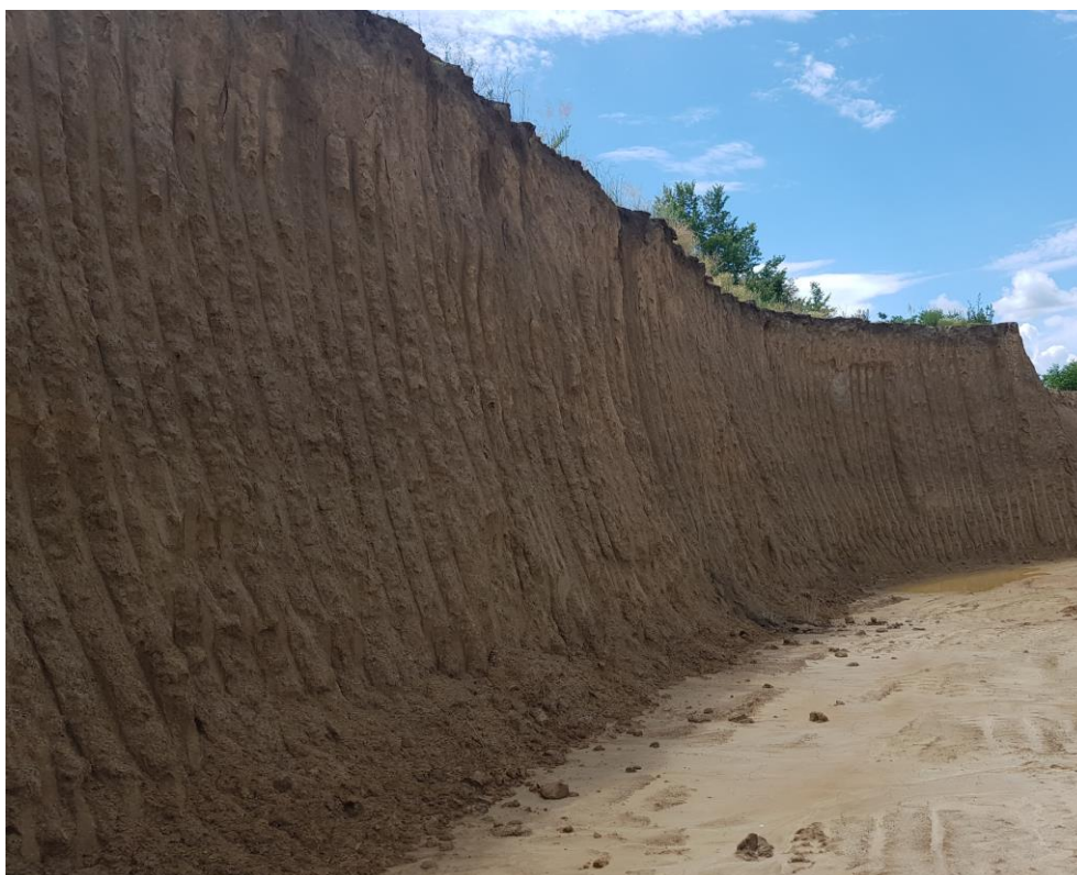
Slika 5.7. Vrlo strmi iskop na lokaciji uzimanja uzoraka u glinokopu
