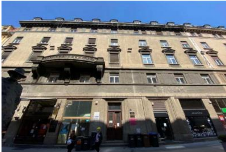
Slika 4.3. - Građevina za dijagnostiku i sanaciju
