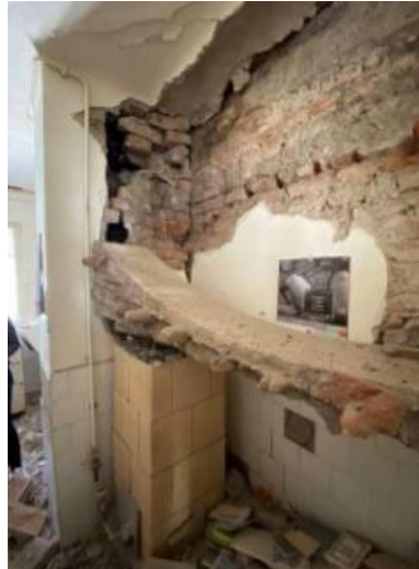
Slika 5.15. - Pogled uzduž krajnjeg istočnog nosivog zida
