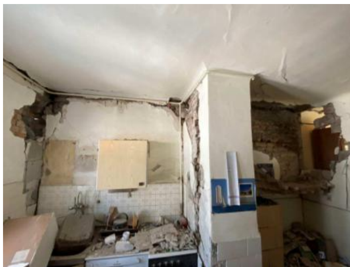
Slika 5.13. - Pogled na krajnji nosivi istočni zid zgrade
