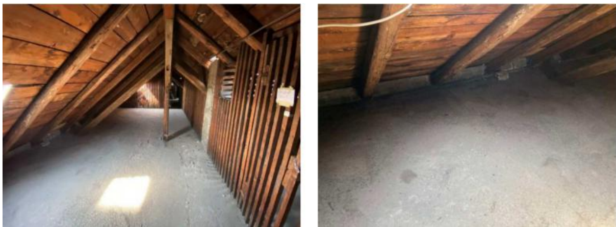
Slika 5.46. - Pogled prema zapadu na sustav krovišta
