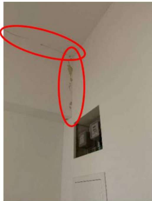
Slika 5.33. - Vertikalne pukotine zidnih gipskartonskih obloga
