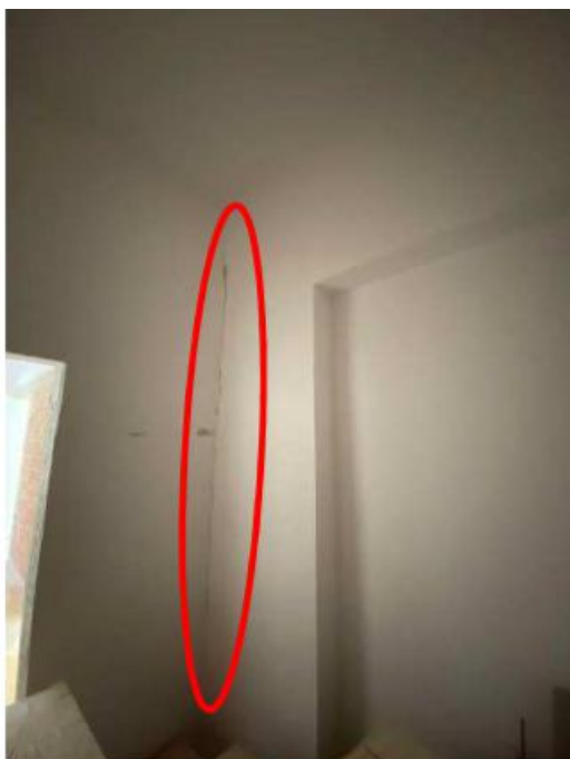
Slika 5.33. - Vertikalne pukotine zidnih gipskartonskih obloga
