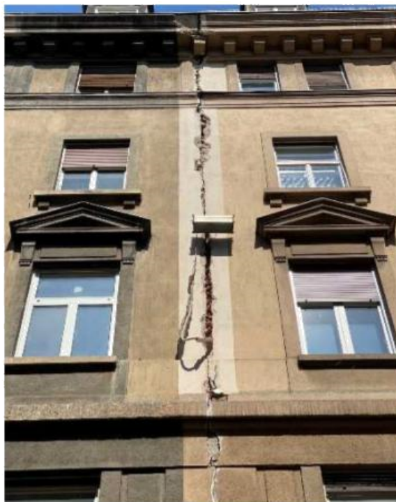
Slika 5.58. - Pogled na vertikalnu istočnu pukotinu
