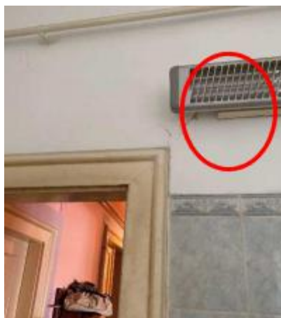
Slika 5.35. - Karakteristična dijagonalna pukotina iz vrata prema stropu (desno)
