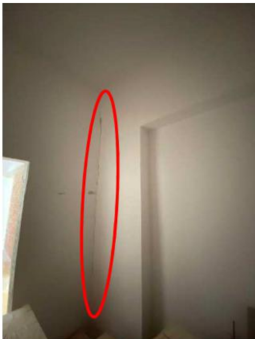
Slika 5.33. - Vertikalne pukotine zidnih gipskartonskih obloga
