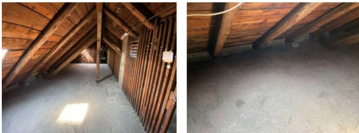
Slika 5.46. - Pogled prema zapadu na sustav krovišta
