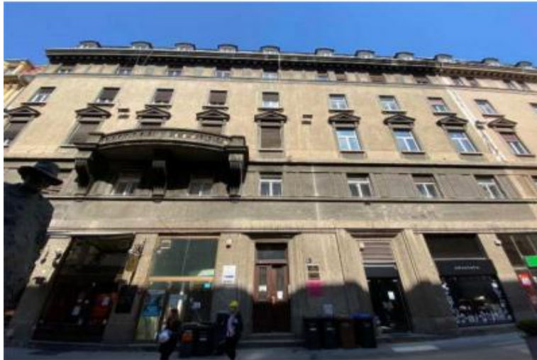
Slika 4.3. - Građevina za dijagnostiku i sanaciju
