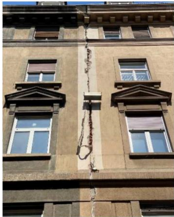
Slika 5.58. - Pogled na vertikalnu istočnu pukotinu
